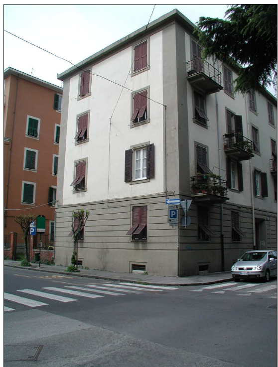
Fotografia fronte su Via Castelfidardo
