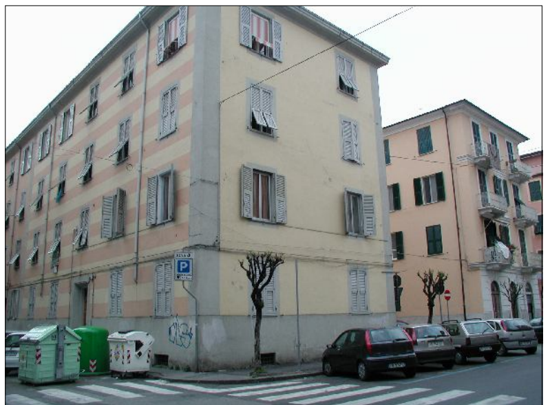
Fotografia fronte su Via Castelfidardo
