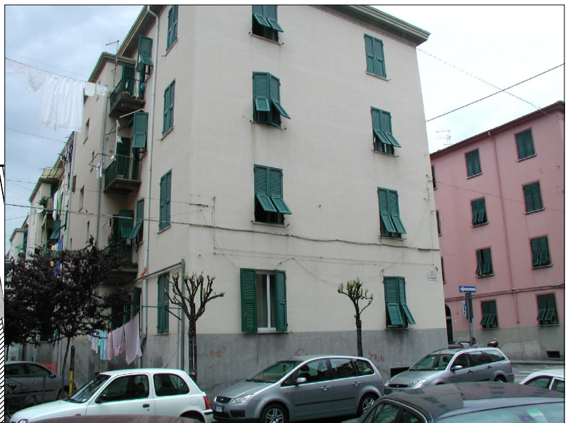
Fotografia fronte su Via Castelfidardo
