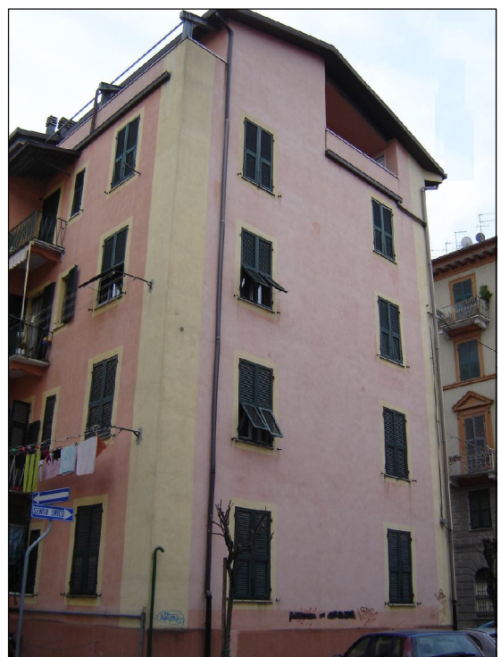
Fotografia fronte su Via Castelfidardo
