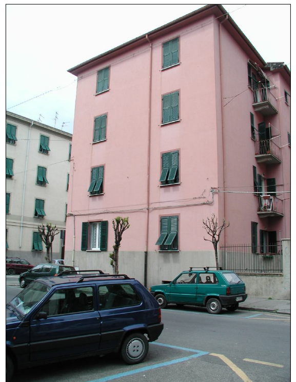
Fotografia fronte su Via Castelfidardo
